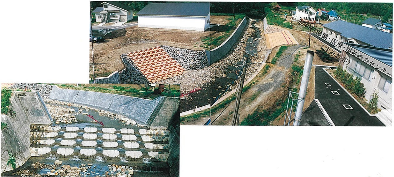
魚道ブロック
