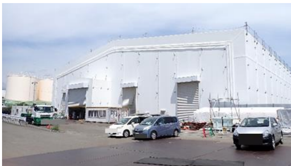
(写真1-1) 既設ALPS建屋の外観 (南東側から撮影)
