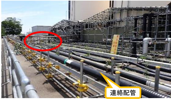
(写真 2 - 4) 既設ALPS処理水連絡配管の状況 ④ (増設・高性能ALPSサンプル タンク北側の状況) (北西側から撮影) ※赤丸付近が連絡配管連結箇所
