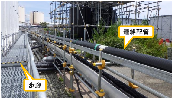
(写真 3) 点検用歩廊の設置状況 (既設ALPS建屋東側を南側から 撮影)
