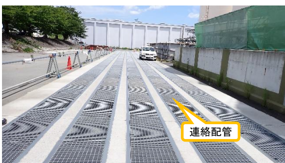
(写真2-3) 既設ALPS処理水連絡配管の状況 ③ (道路縦断部の敷設例) (南側から撮影) ※グレーチング下部の配管トレンチ内に 連絡配管が敷設されている。
