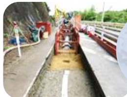
破損した導水管を複線化
