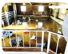
台風による取水場浸水
