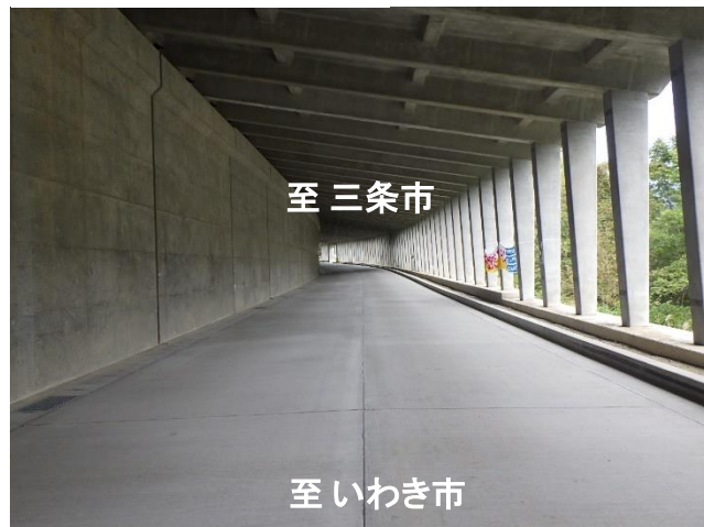
スノーシート工事状況
