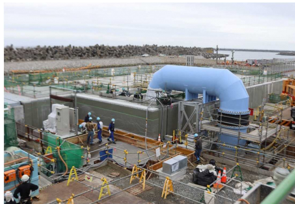
放水立坑(上流水槽)全景
