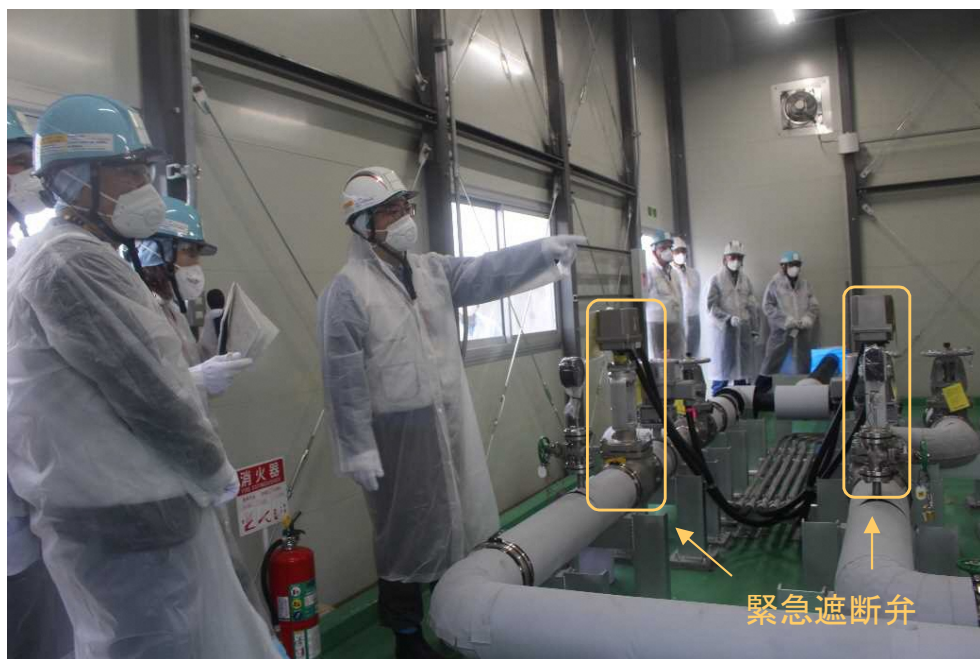
国際原子力機関 (IAEA) による緊急遮断弁の確認 [2023年6月2日撮影]
