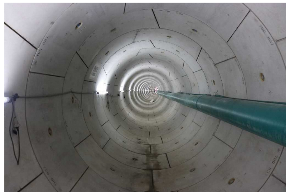
掘進完了後の放水トンネル内
