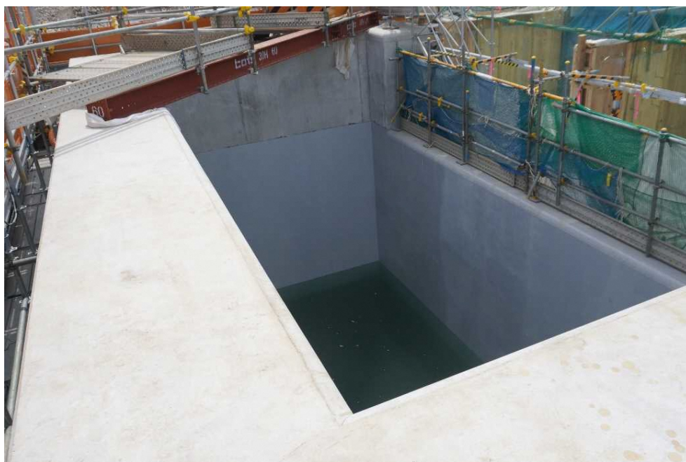
水張り完了後の放水立坑 (下流水槽)
