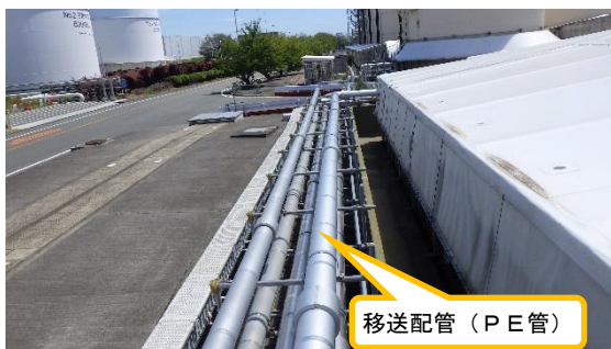
(写真4-2) 直接移送配管（PE管）の敷設状況 （K1北タンクエリアを西側から撮影）
