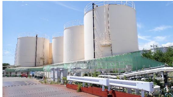
(写真1-2) K1南タンクエリア外観 (北側から撮影)
