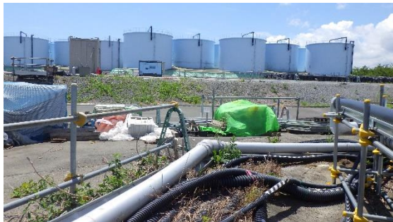
(写真1-3) H1タンクエリア外観 (北東側から撮影)
