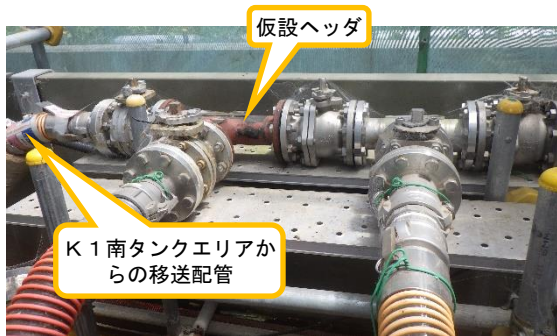
(写真 2 - 3) H 1 東タンクエリア仮設ヘッダへの接続状況
