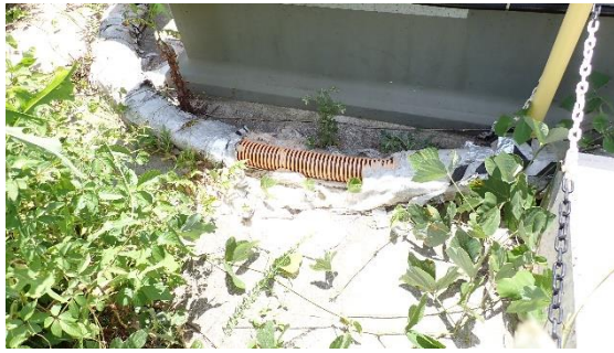
(写真3-2) 移送配管（耐圧ホース）の敷設状況 ②（H1東タンクエリア北東側付近）
