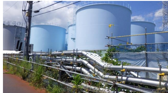
(写真1-4) H1東タンクエリア外観 (南東側から撮影)
