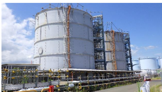
(写真4-3) H9-1～3雨水回収タンクの外観 （北東側から撮影）
