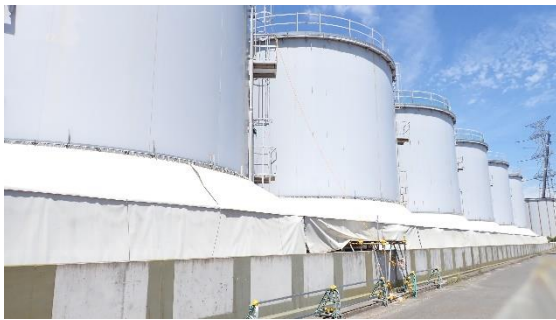
(写真1-1) K1北タンクエリア外観 (南側から撮影)
