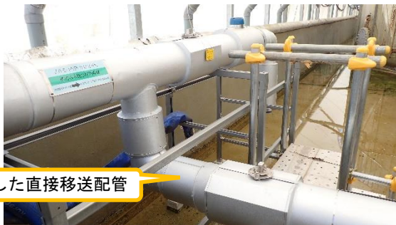
(写真4-1) K1北タンクエリア北東側の移送配管（PE管）の状況
