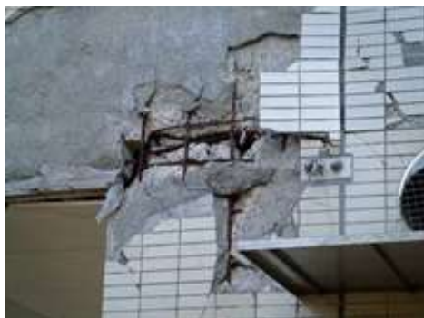
鉄筋爆裂部
