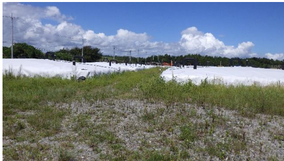
(写真1) 伐採木一時保管エリアGの一時保管槽の概観 (南側から撮影)
