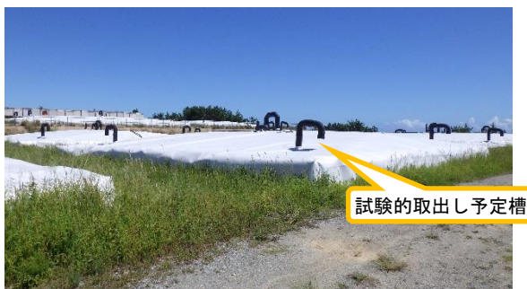
(写真2-2) 伐採木一時保管エリアGの試験的取出し予定の一時保管槽の状況② (南西側から撮影)
