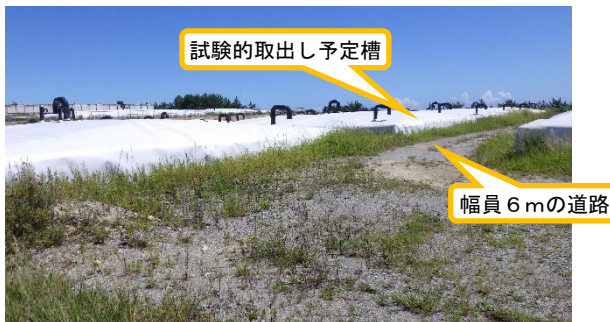
(写真2-1) 伐採木一時保管エリアGの試験的取出し予定の一時保管槽の状況① (南西側から撮影)
