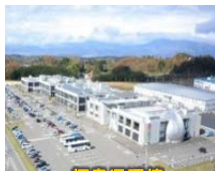
福島県環境創造センター
