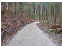
森林作業道の開設
