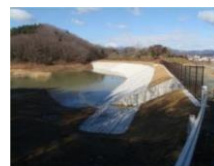
老朽化したため池の改修
