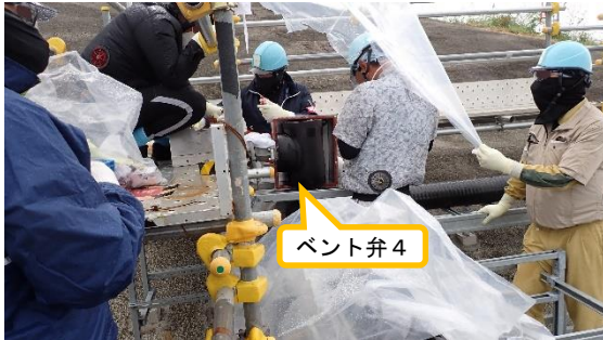
(写真3) ベント弁4点検作業の状況
