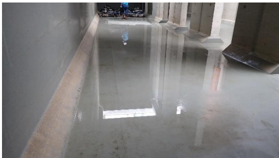
(写真1) 上流水槽床面の状況
