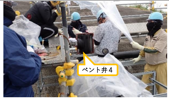
(写真2) ベント弁4の点検作業の状況
