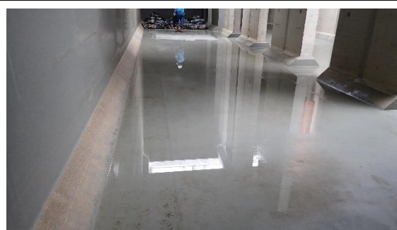
(写真1) 上流水槽床面の状況
