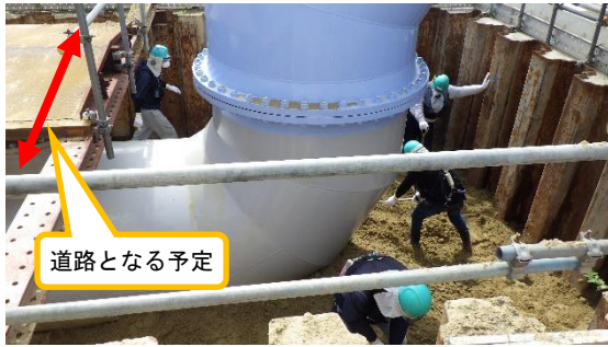
(写真2) 土砂の埋め戻し作業の状況
