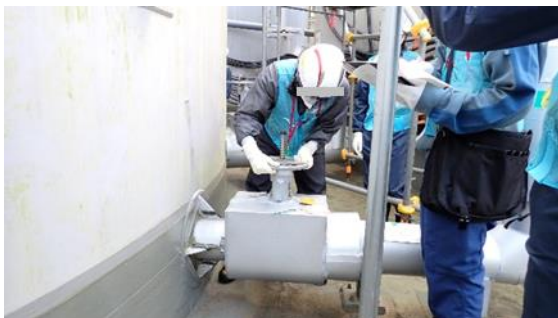
(写真1-2) 連結弁の「全開」操作の状況
