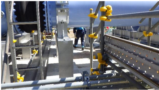
(写真 2 - 2) 海水移送配管の確認状況
