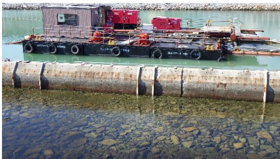
(写真1-1) 1-4号機取水路開渠内に浮かぶユニフロート台船
