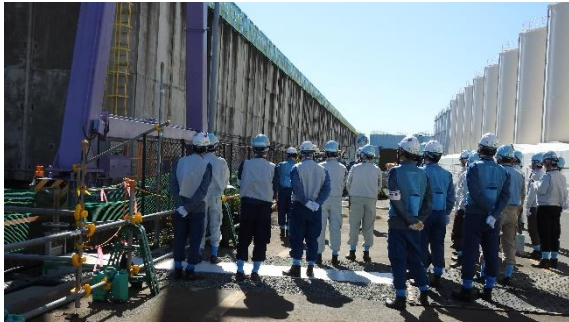
(写真 2 - 2) 第三施設の確認状況 (北側から撮影)
