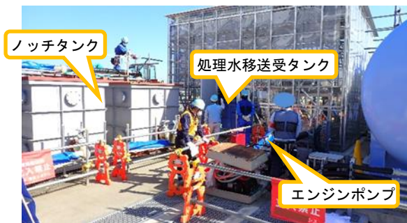
(写真2) 処理水置換作業の概観
