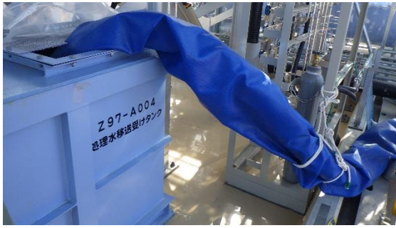
(写真3-1) 移送用耐圧ホースの敷設状況
