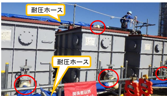
(写真3-3) ノッチタンクの状況 ※赤丸印が接続部の吸水材養生
