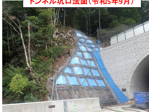
トンネル坑口法面(令和5年9月)
