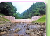
治山施設の整備
