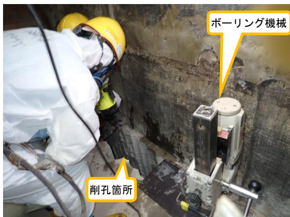
(写真1-2) ボーリング機械による削孔の状況①
