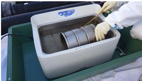
(写真5) ストレーナ内部のスクリーンの洗 浄の状況
