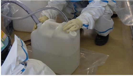
(写真3) ストレーナ周辺配管内の水抜き の状況
