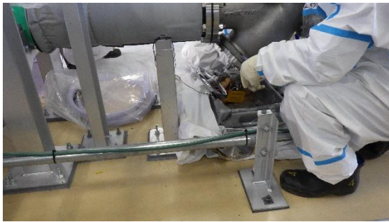
(写真4) ストレーナ取り外しの状況
