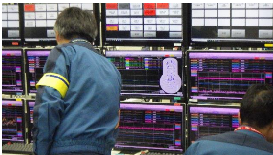
(写真1) プラントパラメータを監視している 状況
