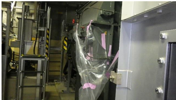
(写真2-1) 5号機R/B排風機 (A) の養生状 況 (北西側から撮影)
