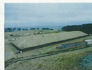
1槽目の状況 (H25/3/27撮影)
