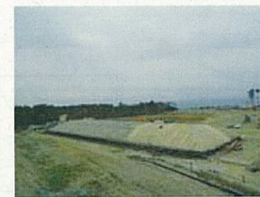
2槽目の状況 (H25/3/25撮影)
