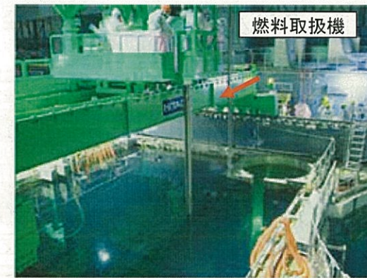
燃料取り出し作業
