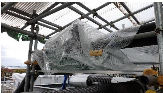
(写真2-1) 仮設移送配管の状況
