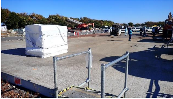
(写真 2 - 1) 燃料を回収する設備のシート養生の 状況 (南西側から撮影)
