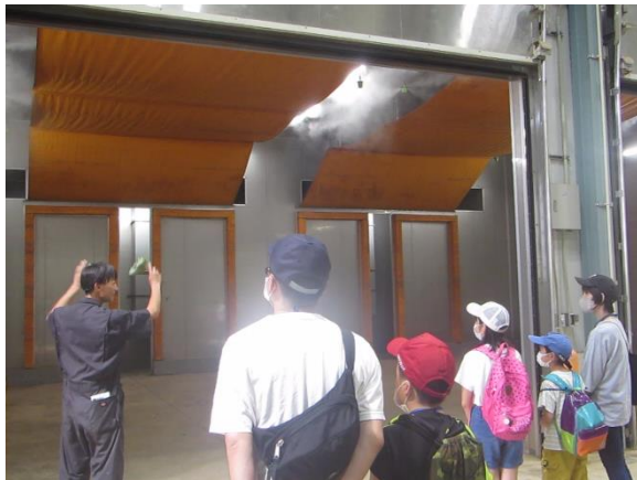
檜葉町甘藷貯蔵施設での施設説明
