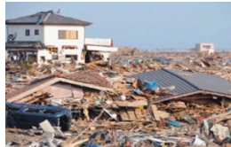
津波被害：浪江町
