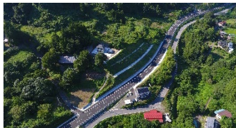
国道349号（川俣町大綱木工区） 2023年3月21日 供用
