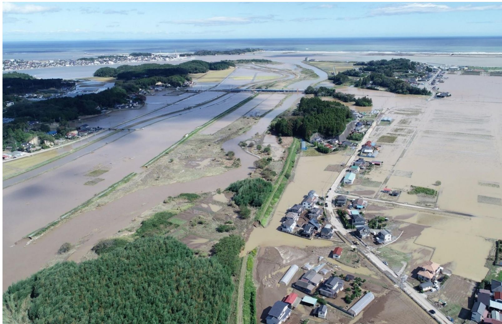
令和元年度台風19号被災状況(宇多川・小泉川・国道6号下流)
