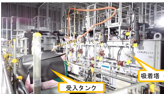
(写真3) 受入タンクの状況 (南東側から撮影)
