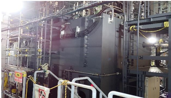
(写真6-2) 増設ALPS (A系) の前処理設備 改造工事の状況② (北西側から撮影)
