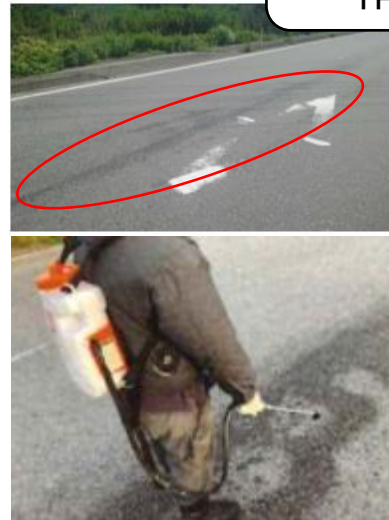
【漏出状況と中和処理】
