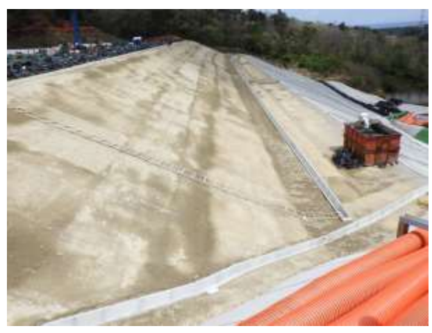
土堰堤の施工状況
