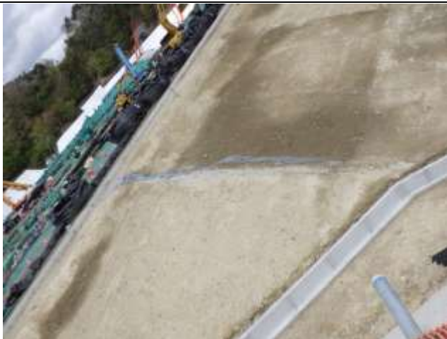
クラックの補修状況
