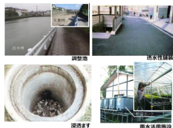
雨水貯留浸透施設の例
