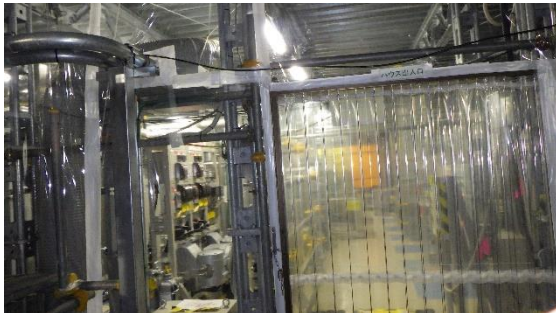
(写真1-1) 3号機タービン建屋内塩害対策ハウス入口の状況
