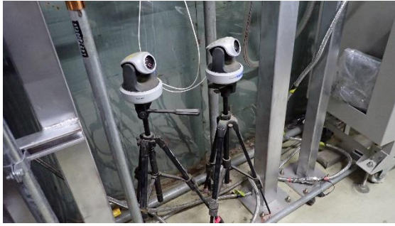
(写真2) 遠隔監視カメラ
