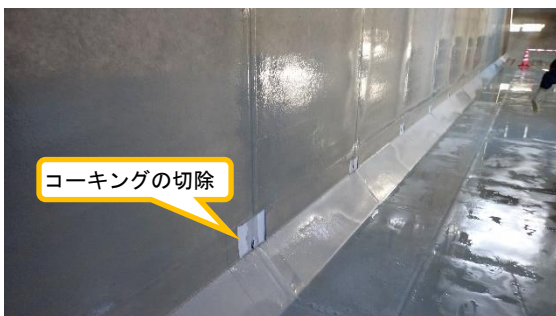
(写真2) 目地のコーキング切除及び水抜き の状況
