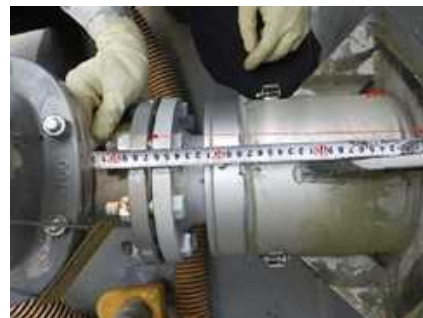
現場寸法確認
