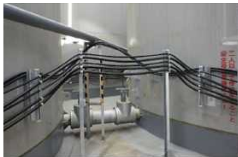
現場環境調査
