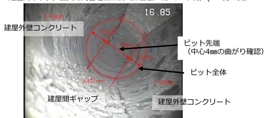
建屋間ギャップ直交方向管理結果例（許容値：約20mm未満）（1-1孔の例）
