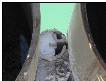
【継手部写真（モルタル充填後）】
