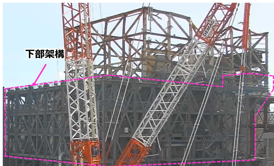
現場状況（北西面） （撮影：2024年1月24日）
