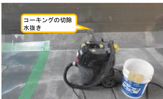
(写真 2 - 2) 目地のコーキング切除及び水抜きの 状況②
