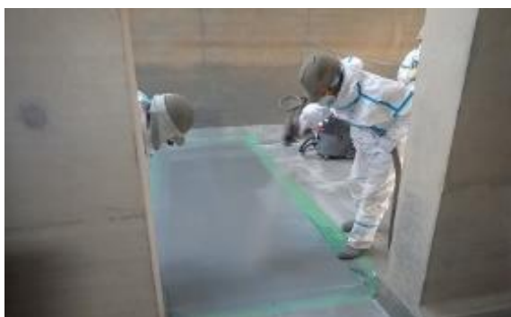
(写真 1 - 2) 防水塗装の状況②
