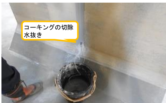
(写真 2 - 1) 目地のコーキング切除及び水抜きの 状況①
