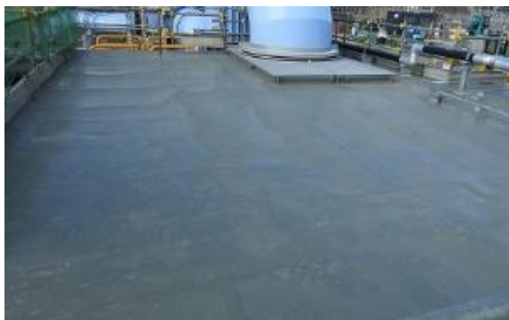
(写真 3) 頂版上の防水塗装完了後の状況
