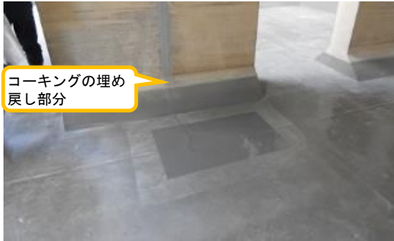
(写真 2 - 3) 目地のコーキング切除及び水抜き の状況③
