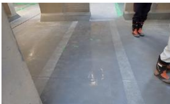
(写真 1 - 3) 防水塗装の状況③
