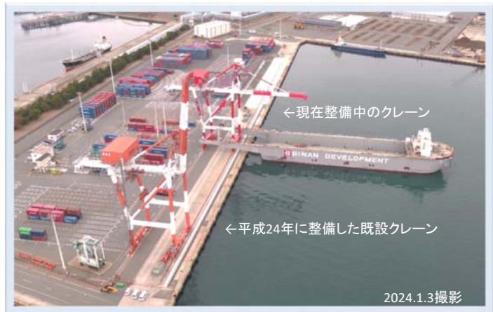
クレーン陸揚げ状況
