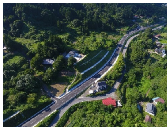
国道349号大綱木工区
