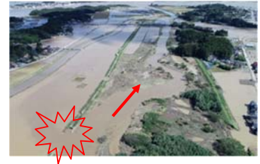
出水時(堤防破堤)
