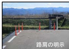
町道分離措置
