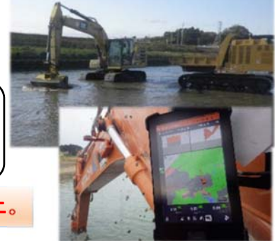
樹木伐採・河道掘削着手後 (令和4年7月撮影)
