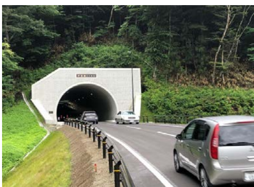
開通した野上小塚工区
