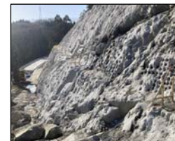
資料 3-2 掘削困難箇所の地肌状況
