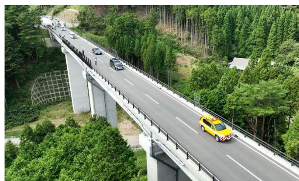
国道399号十文字工区 バレドの様子(令和4年9月17日)
