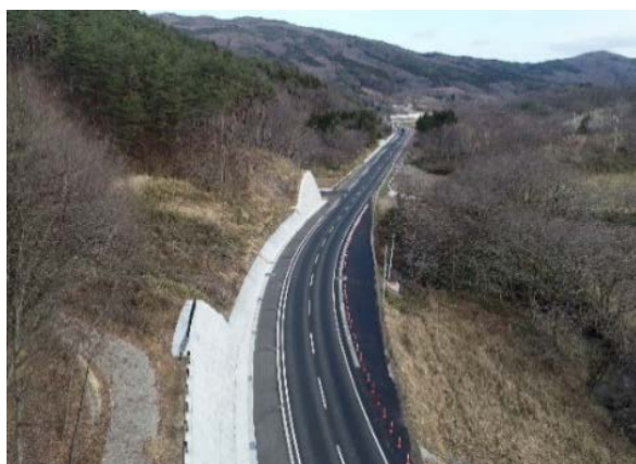
国道114号山木屋工区
