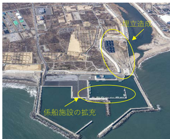
復旧工事完了後の請戸漁港
