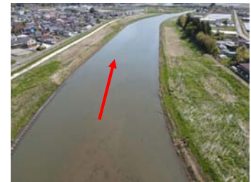
整備完了状況
