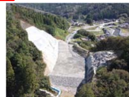
資料 5 現掘削状況(令和5年12月撮影)
