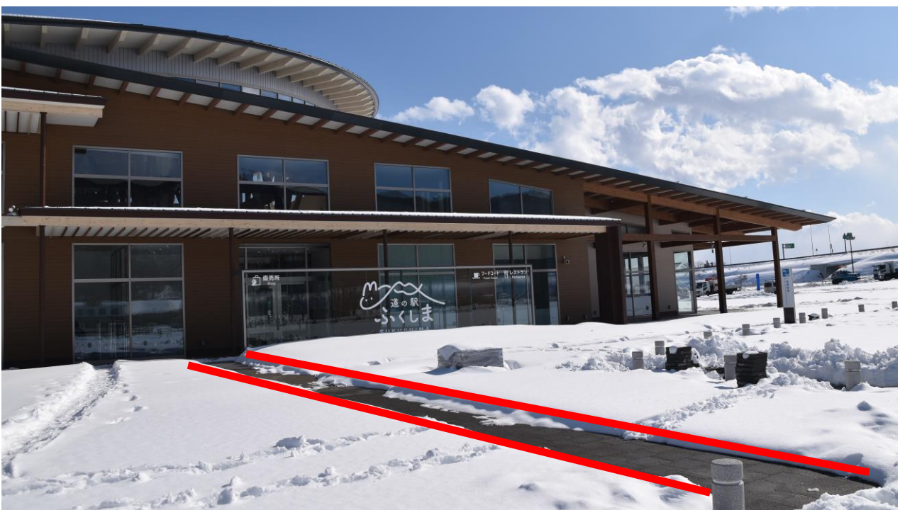
【融雪設備の稼働により歩行者の導線を確保】
