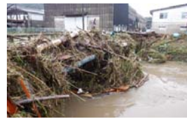
<橋に堆積した支障物>
