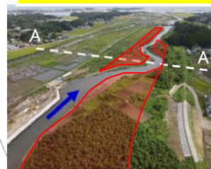
樹木伐採・河道掘削着手前 (令和2年9月撮影)
