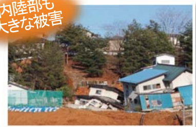
家屋被害の状況（福島市伏拝地内）
