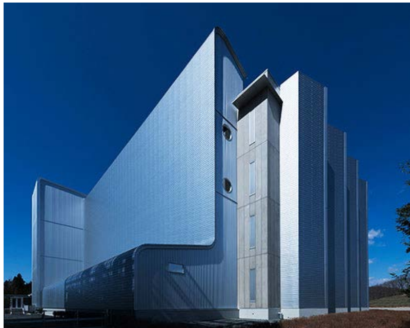
●2012年 白河データセンター稼働開始
