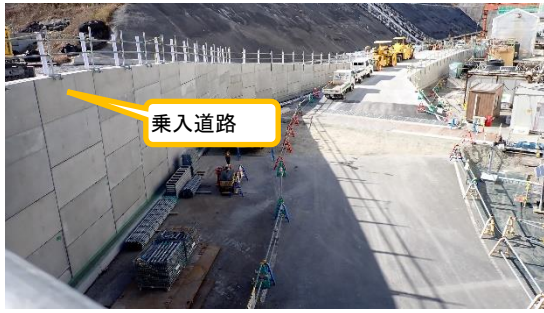
(写真6) 乗入道路の整備状況 (プロセス主建屋南側) (東側から撮影)
