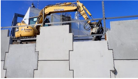
(写真3) 防潮堤本体の施工状況 (4号機タービン建屋東側)
