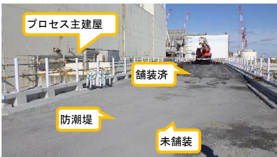
(写真5) 防潮堤の状況 (プロセス主建屋東側) (南側から撮影)
