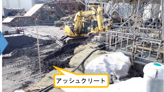
(写真4-2) 防潮堤の状況 (令和5年11月29日) (4号機タービン建屋南側) (北側から撮影)
