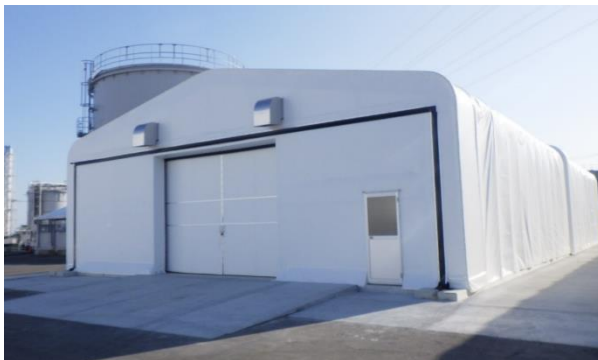
(写真1-1) 堆積物除去装置（高圧水・AWJ）の保管施設 （大型機器点検建屋近傍の海側テントハウス）
