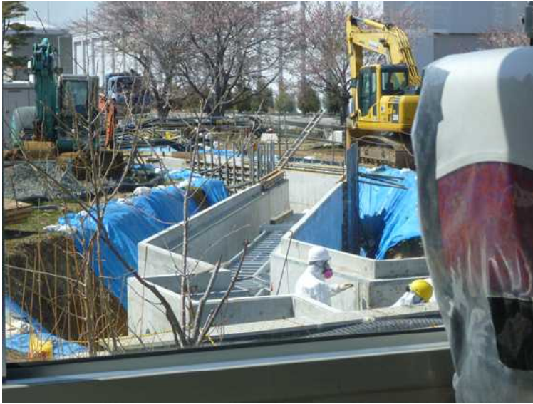
○ケーブルトレンチ本設化 作業高圧電源盤増設工事 場所
