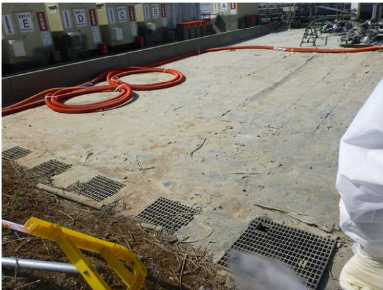
○H6タンクエリア 地下水観測孔G-2付近 の汚染水漏えい箇所
