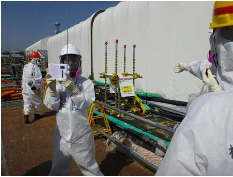
○H6タンクエリア 地下水観測孔G-2
