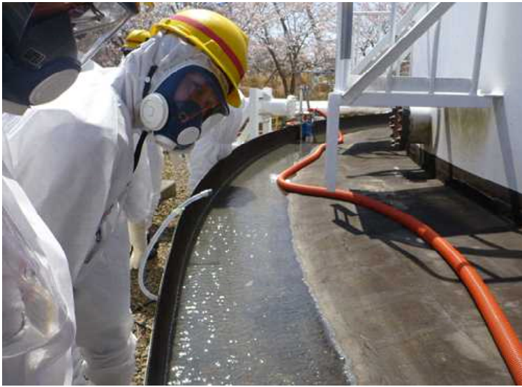
○ろ過水タンクエリア堰の 状況
