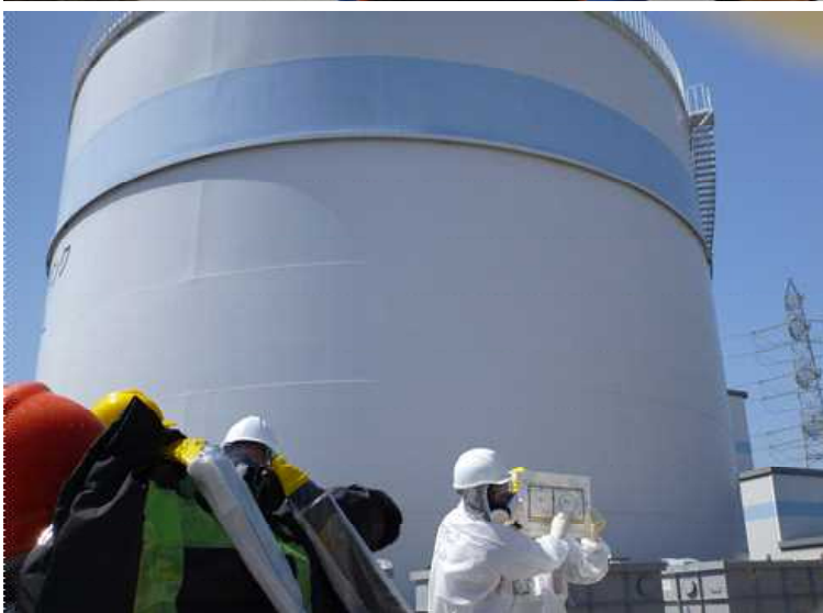
○ろ過水タンクエリア堰 からの雨水溢水に関する 現場説明状況
