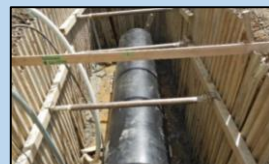
導水管布設（開削工法）
