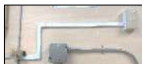
図19 合成樹脂線び工事
