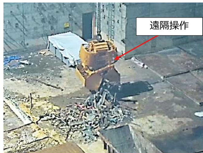
＜遠隔操作式クレーンによるガレキ回収
