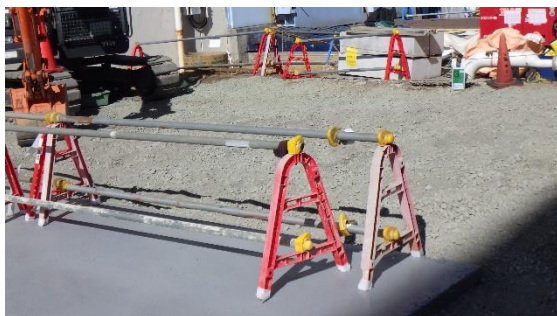
(写真2-1) 同コンクリート盤北側砕石地盤の状況
