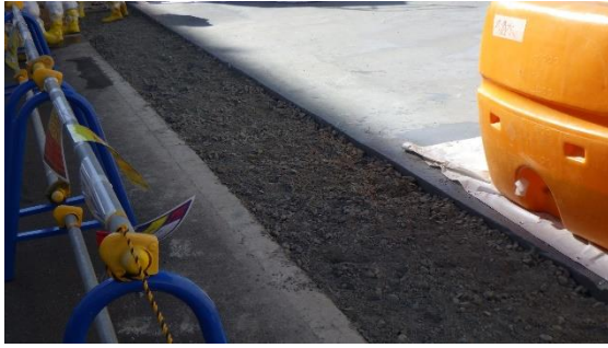
(写真2-2) 同コンクリート盤東側砕石地盤の状況
