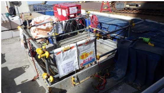
(写真3) K排水路への入口
