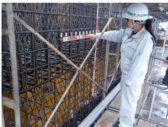
↑現場確認の様子
