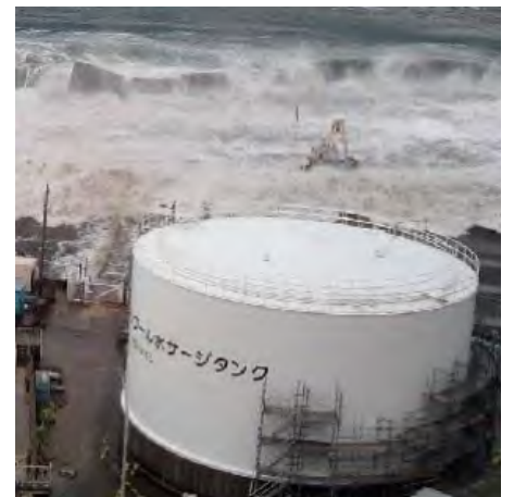
⑤ 原子力発電所に津波がおしよせる様子
